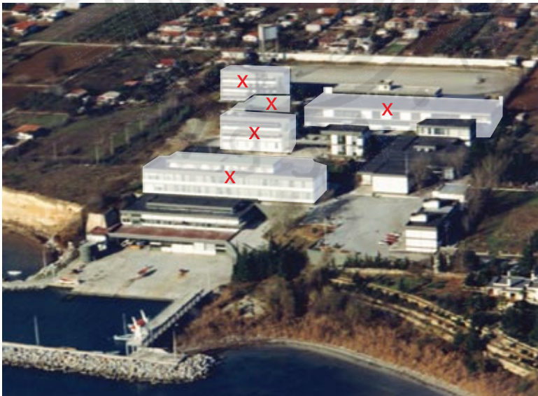
Οι κτηριακές εγκαταστάσεις της ΑΕΝ Μακεδονίας με X τα κτήρια που έχουν εγκαταλειφθεί λόγω χαρακτηρισμού τους ως επικίνδυνα.
