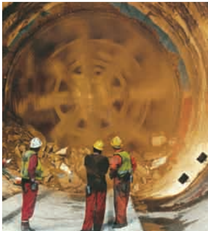
Μηχανικός εκσκαφέας που χρησιμοποιήθηκε για τη διάνοιξη της Σήραγγας της Μάγχης επί τω έργω.
